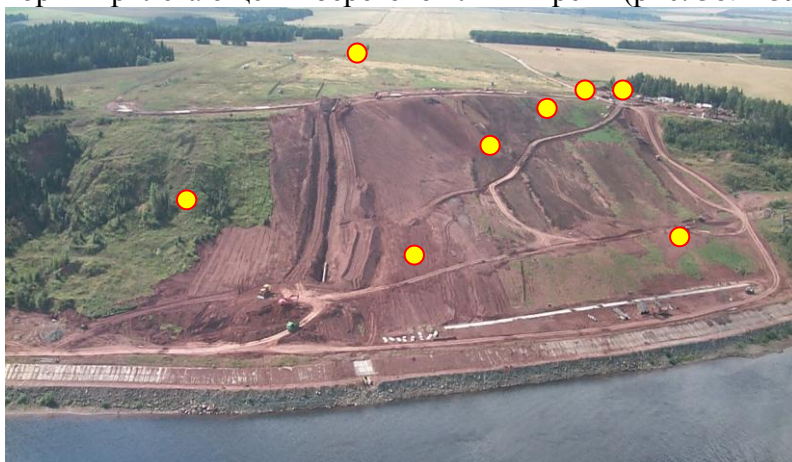
Рис 38. Переход магистрального газопровода через р. Кама, Удмуртия.
